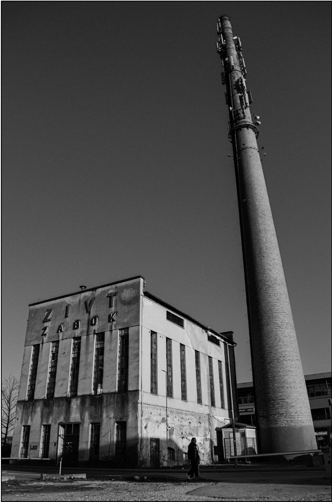
Kotlovnica i dimnjak ZIVT-a - Zabok
